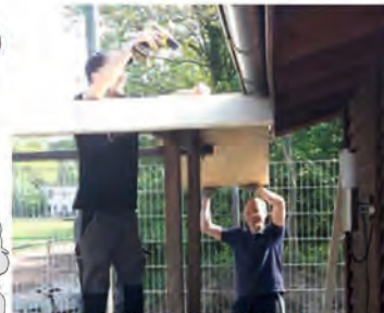
Fleißig: Björn Glaser (rechts) baut mit Tomasz Musiol ein neues Dach über der Grillecke.
